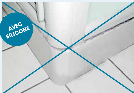
Montage d'une paroi avec joint silicone
